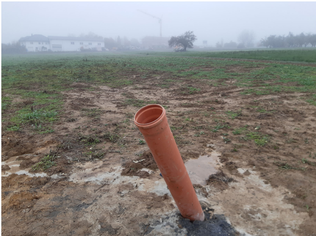
Foto 2: EWS nach Abbau des Testgeräts
